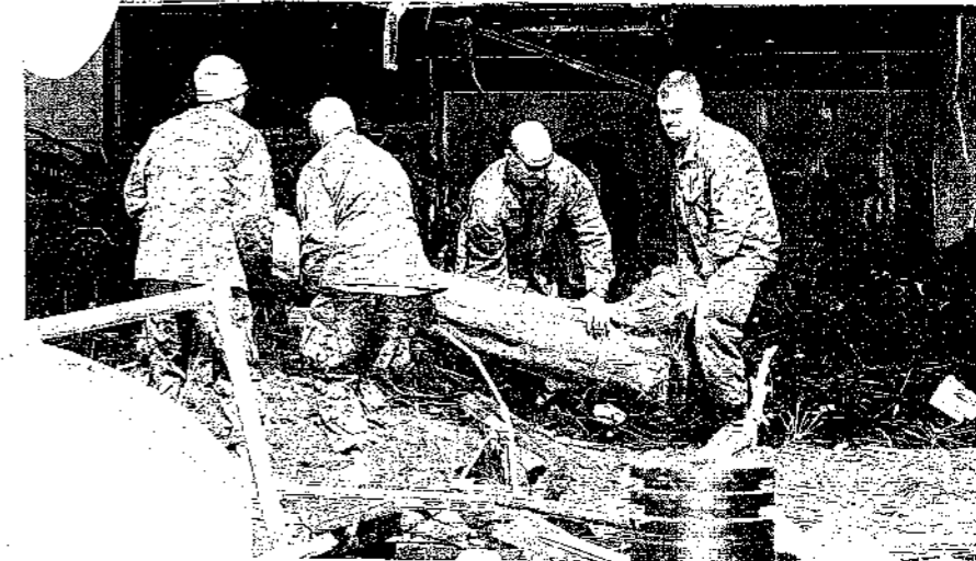
仙台空港のターミナルビル出入り口に堆積した流木や瓦礫を手作業で取り除く、米海兵隊員。津波で破壊された仙台空港の復旧を担ったのは米陸空軍・海兵隊だ。特殊作戦用輸送機で重機を降ろし、滑走路を再開。修復機材を積んだ輸送機を次々と降ろし、日本の土木業者と共同で作業し再生させた。
